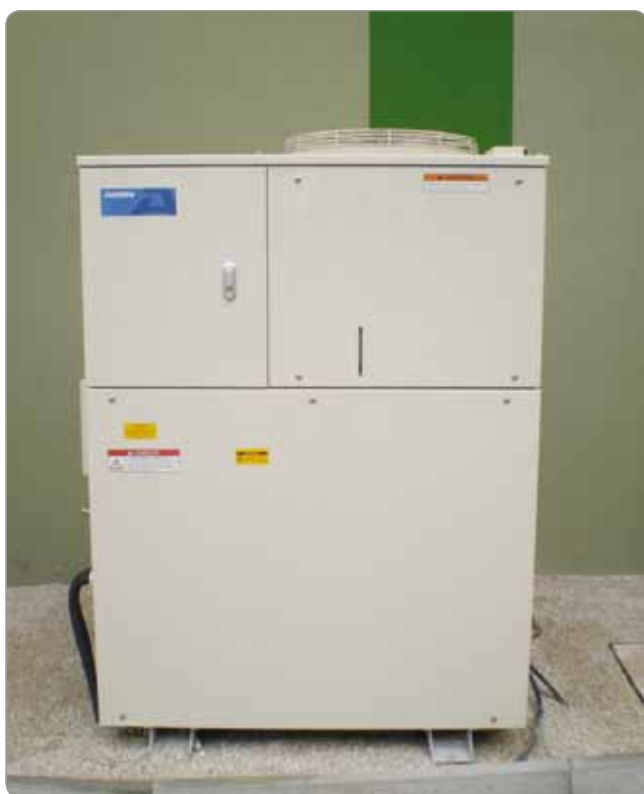
Obr. 5 Kogeneračná jednotka
